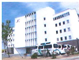
未来創造館 (フロントサービス付き賃貸マンション)
